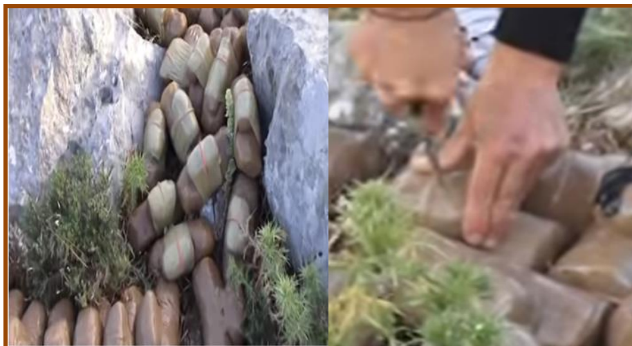
Εικ. 13 (α-β): Η τοποθέτηση των δυναμιτών ανάμεσα στους βράχους και το φυτίλωμα.
